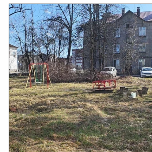
Демонтаж элементов благоустройства
